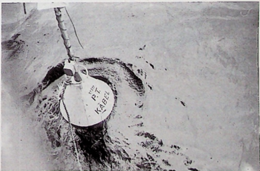
Versterker ligt aan dek gereed om in zee te worden neergelaten.
